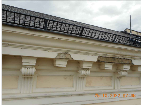
Ilustrační foto stávajícího stavu poškozené spodní části římsy - Trakt "D"
