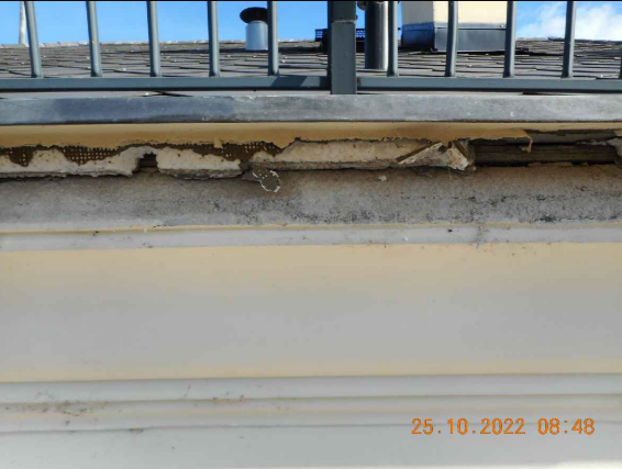
Ilustrační foto stávajícího stavu poškozeného čela římsy - Trakt "C"
